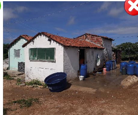
Figura 76 - Queijaria com arredores inadequados
