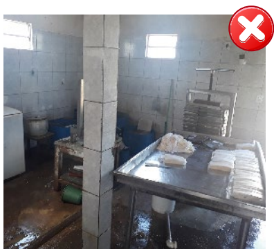
Figura 47 - Acúmulo de água e sujeira no piso
