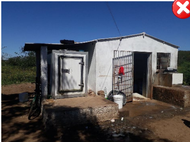
Figura 81 - Degradação da terra causada pelo soro
